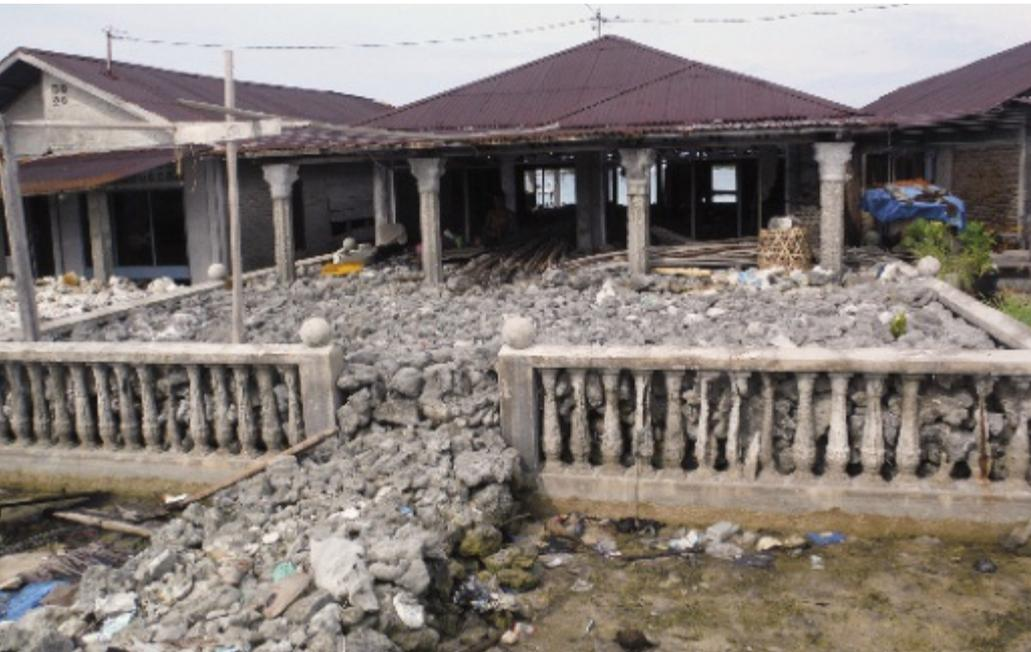
Nach einem Tsunami musste vor etwa 14 Jahren die Bausubstanz mit Korallen aufgefüllt werden.
